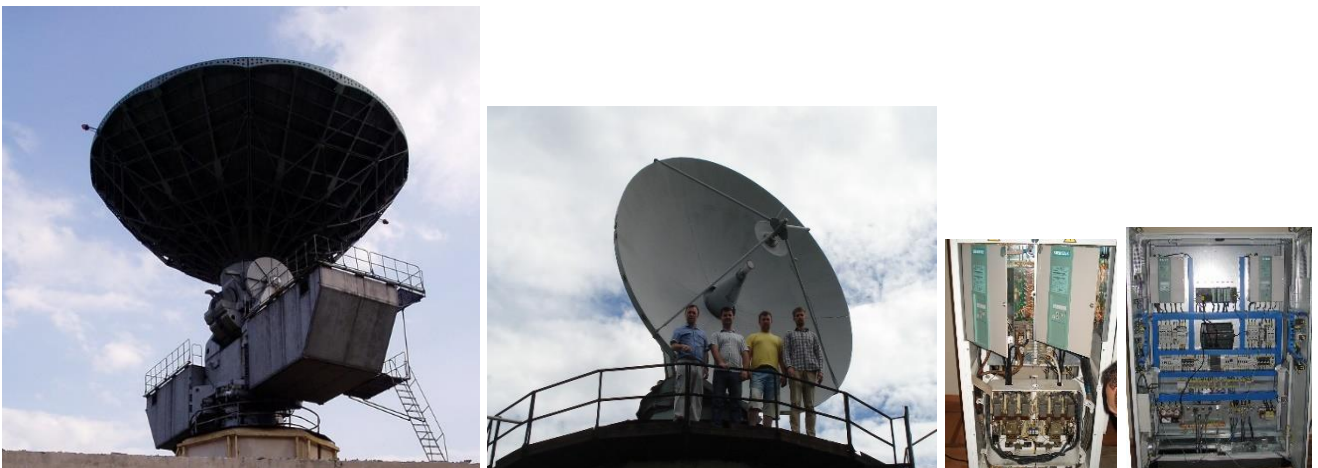
Рис.2 Антенні системи ТНА-57, «Кристал-5м» та електронні вузли системи управління в ЦПОСІ і КНП
